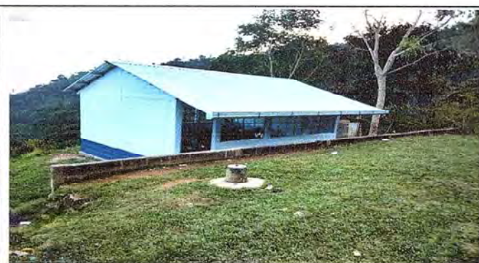
Foto 3: Cambio de lamina y estructura de aula.
