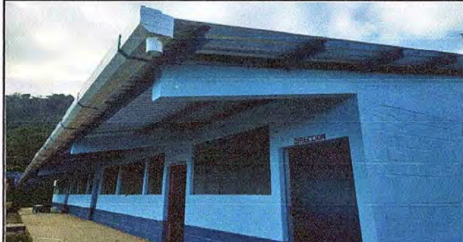
Foto 2: Colocación de canal en ambos lados del establecimiento.
