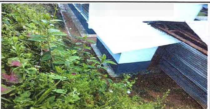
Foto 5: Cambio de lámina de baños.
